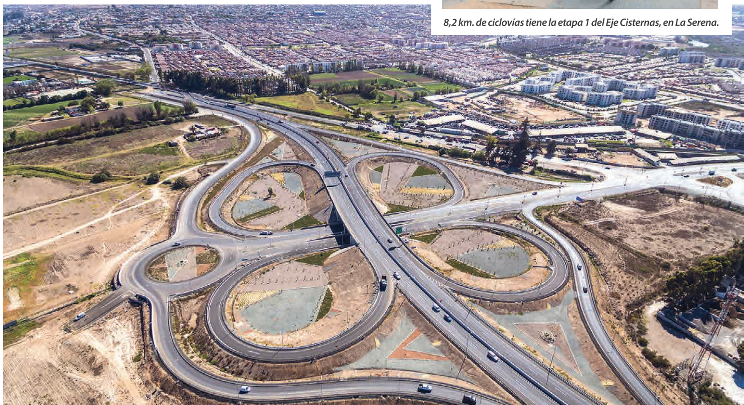
Acceso a Las Compañías en la doble vía La Serena Vallenar. Fotografía cedida por concesionaria Ruta del Algarrobo.
