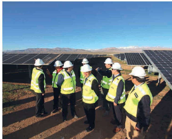
Parque solar El Pelicano en La Higuera, abastece a Metro de Santiago.
