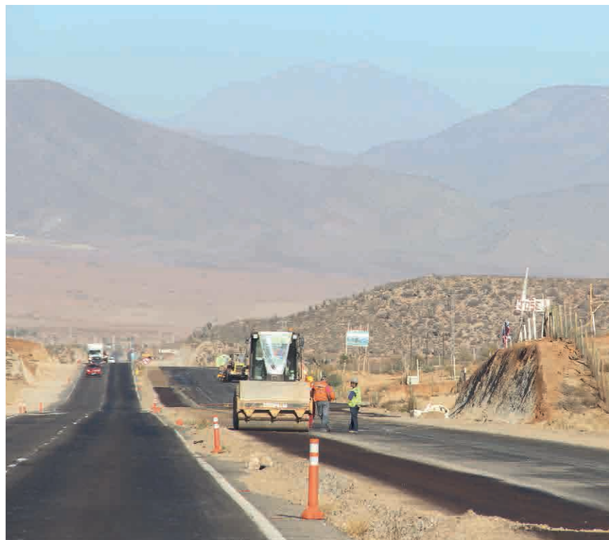
Trabajos de la doble vía Ruta D-43 a Ovalle - Coquimbo.
