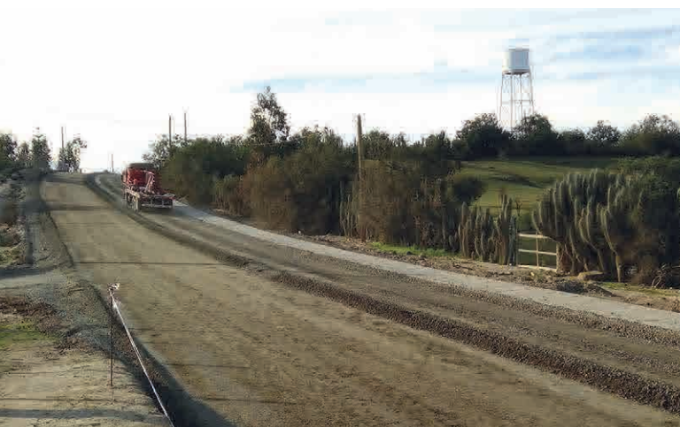
Obras ruta Soruco Manquehua que une Combarbalá y Punitaqui por caminos interiores.
