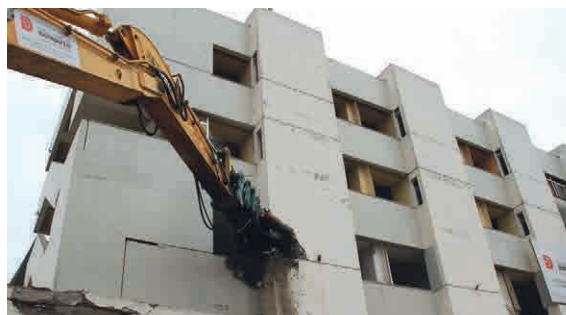
Demolición de torre antigua Hospital San Pablo de Coquimbo.
