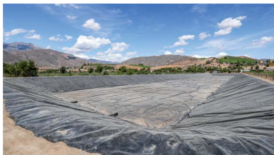
Tranque Chañaral Alto, obra para sequía, inaugurado recientemente en la localidad ubicada en la comuna de Monte Patria.
