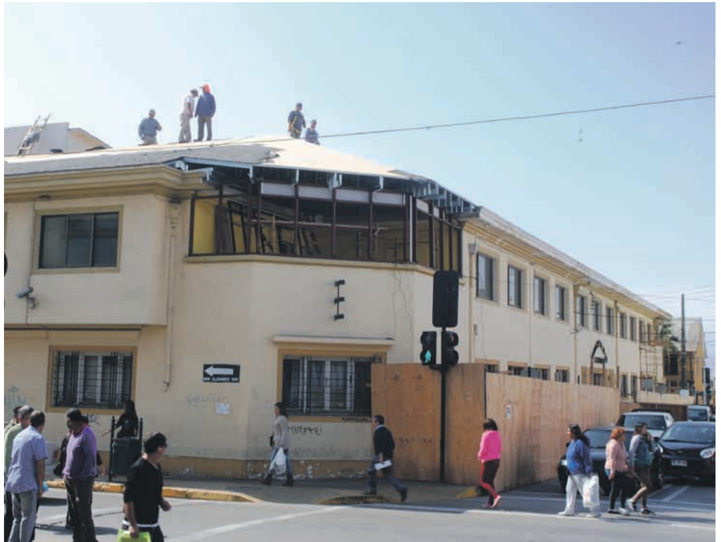
En el siniestrado edificio municipal de calle Bilbao en Coquimbo se realizan trabajos para su puesta en funcionamiento y el traslado de reparticiones municipales.
