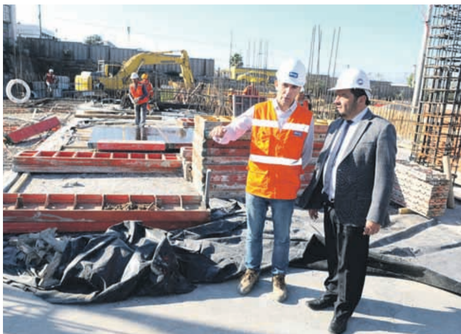
El edificio municipal de Coquimbo ya posee un 32% de avance en su construcción y se busca que esté habilitado y entregado a la comunidad en marzo del 2016.
