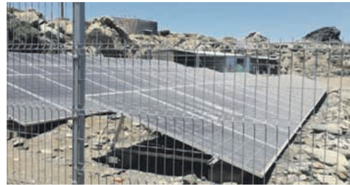
Con paneles solares funciona la planta desalinizadora que actualmente está en período de prueba
