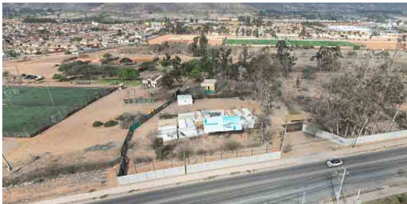
Largo tiempo llevan detenidas las obras del hospital de La Serena.
