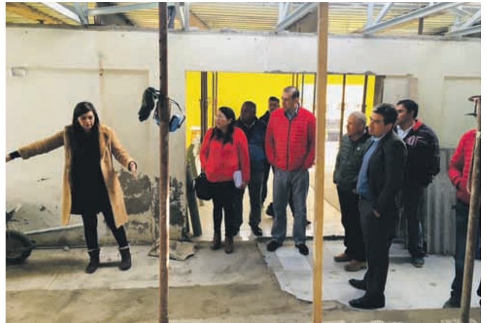
Actualmente, los maestros ya trabajan en la obra gruesa del restorán.
