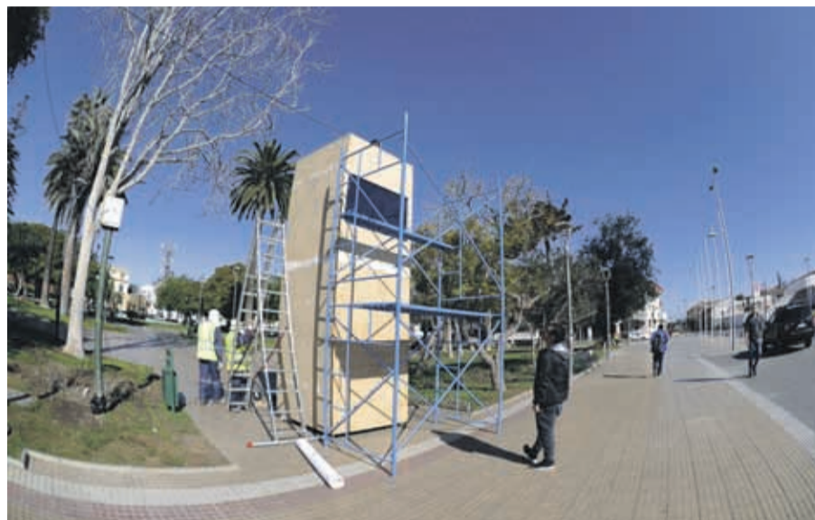
La estructura ubicada en la plaza de armas serenense estará lista en los próximos días
