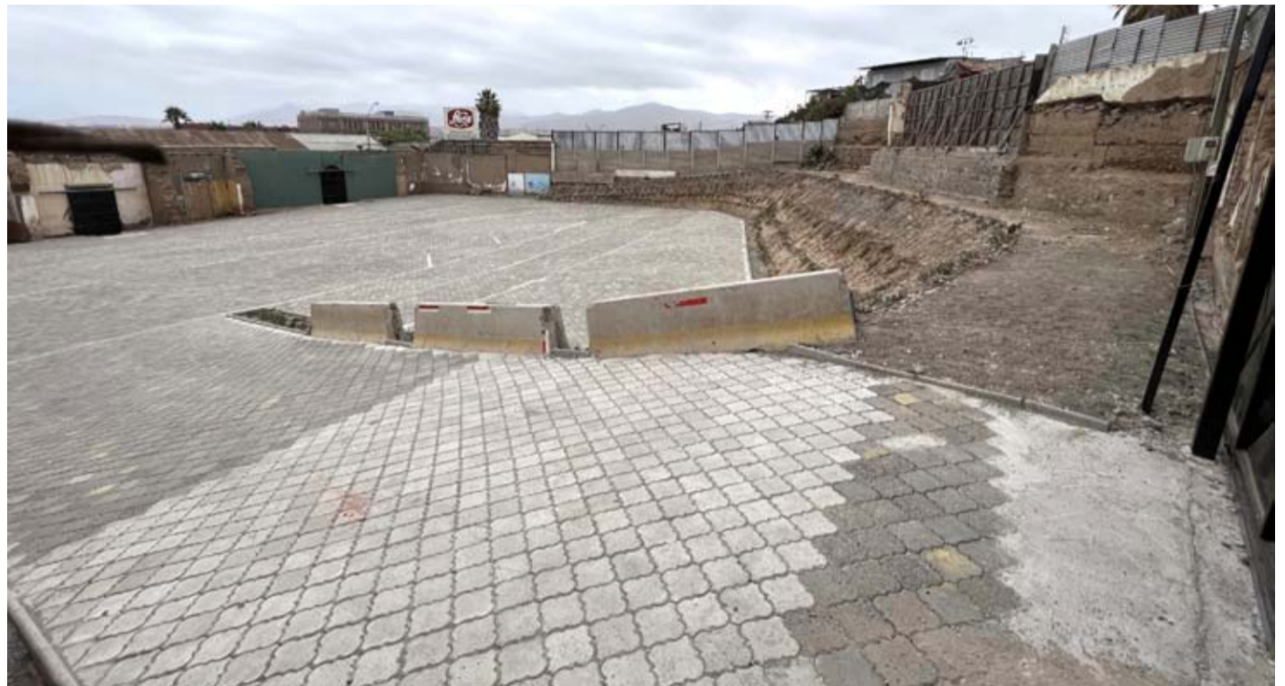
Así se levanta el nuevo recinto que albergará a los comerciantes que optaron por la formalización.
