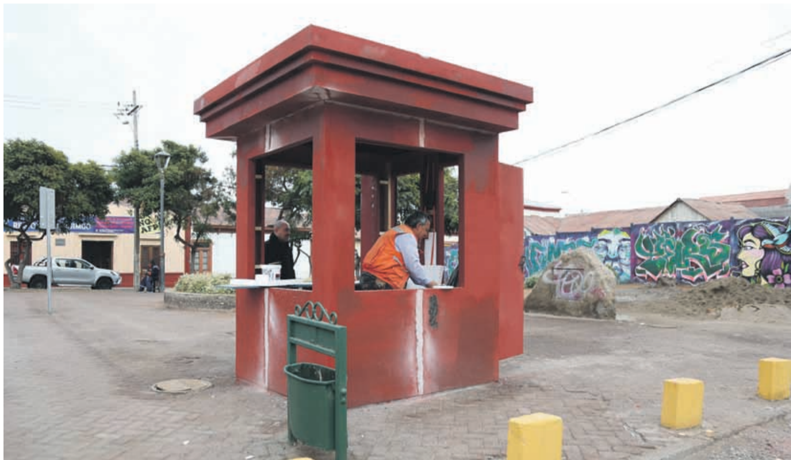
Los trabajos al interior de la caseta de seguridad de Plaza Tenri prosiguen.
