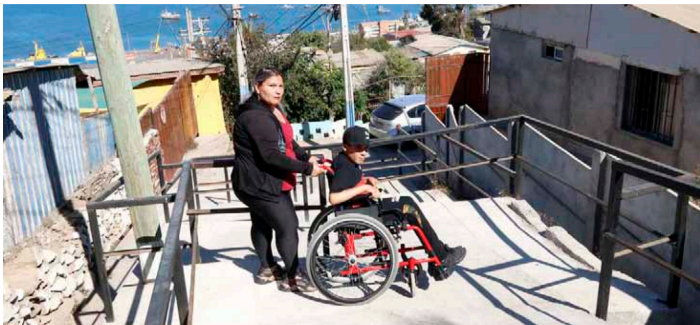
La escalera en zig zag, se encuentra ubicada en la Parte Alta de Coquimbo, en particular, en calle Argandoña.
