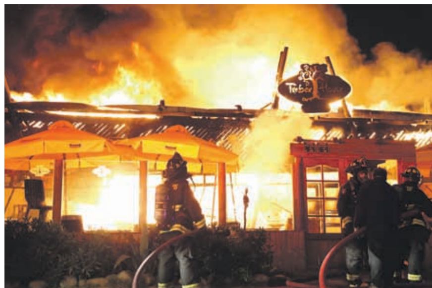
El fuego consumió en forma muy rápida la estructura de madera.
