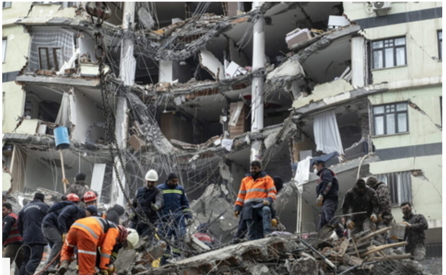
Edificios completos se han derrumbado en Turquía tras los últimos terremotos.
