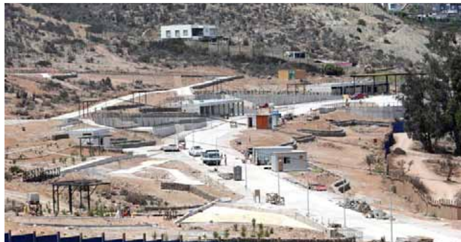
A paso firme avanzan las obras del futuro parque.
