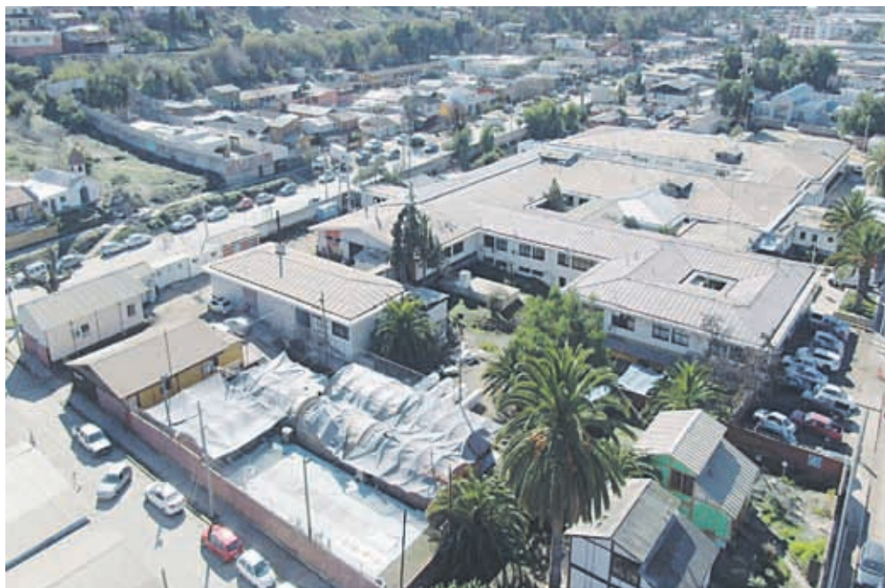
La carpa armada por el Ejército de Chile cuenta con 20 camas básicas y 10 monitores de signos vitales, es de estructura armada con un esqueleto inflable, está montada sobre una superficie que le permitiría estar sobre cualquier tipo de terreno, soportando diversas condiciones tales como viento, lluvia y hasta 10 cms de inundación.
