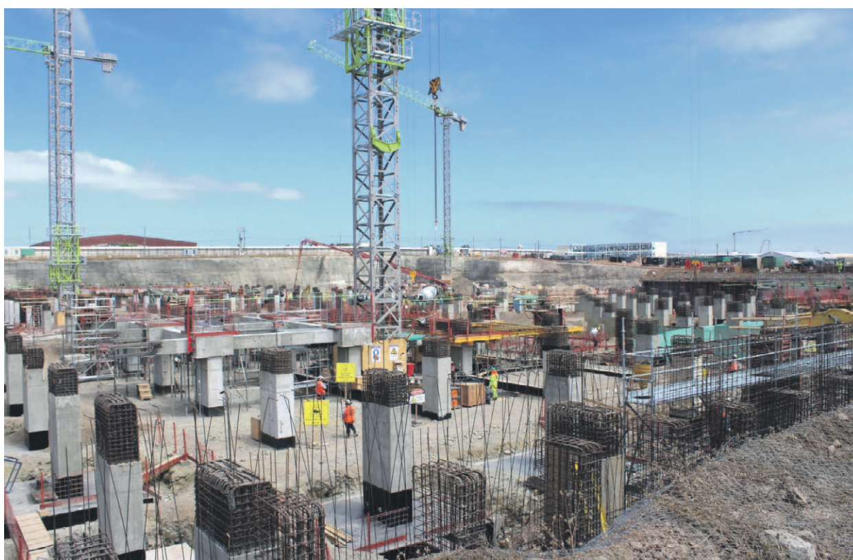
El nuevo hospital de Coquimbo avanza en su construcción y se espera que entre en operación en el año 2028. Las obras las realiza la empresa China Railway Construction Corporation.
