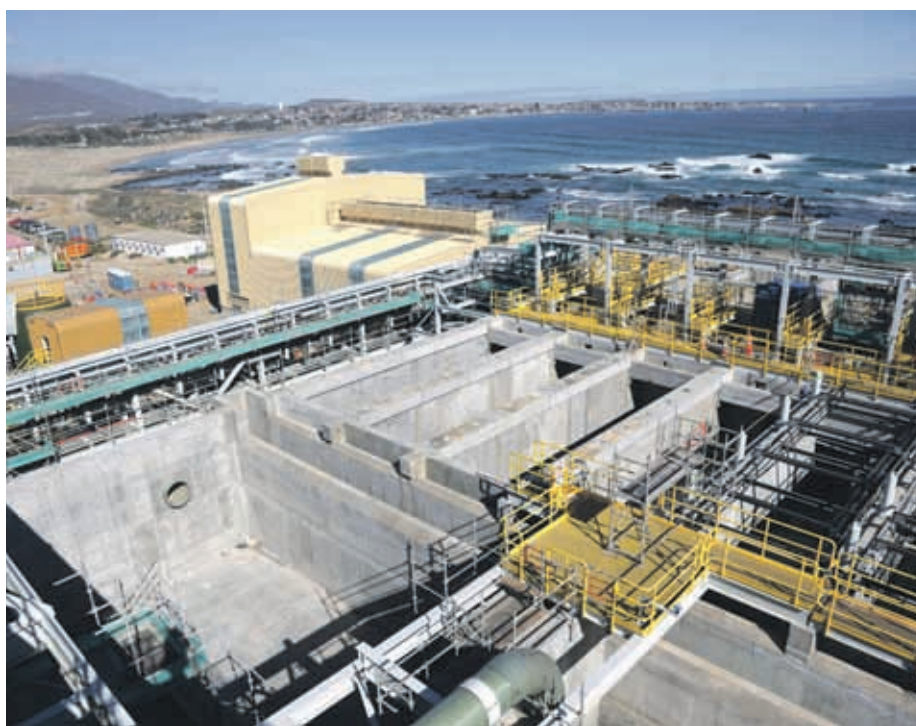
El proyecto INCO contempla instalar en la comuna de Los Vilos una planta desalinizadora de osmosis inversa, obras marinas de captación de agua de mar y descarga de salmuera.
