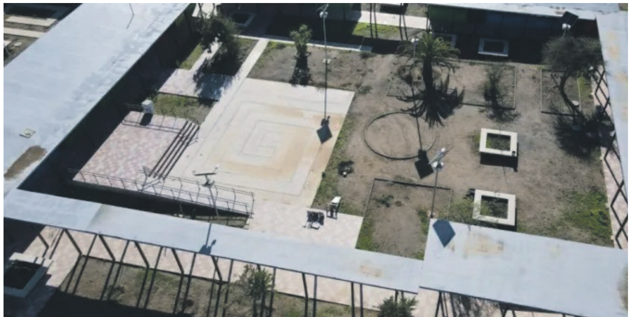
La Escuela San Antonio de Barraza permanece con sus obras paralizadas desde el 5 de noviembre.
