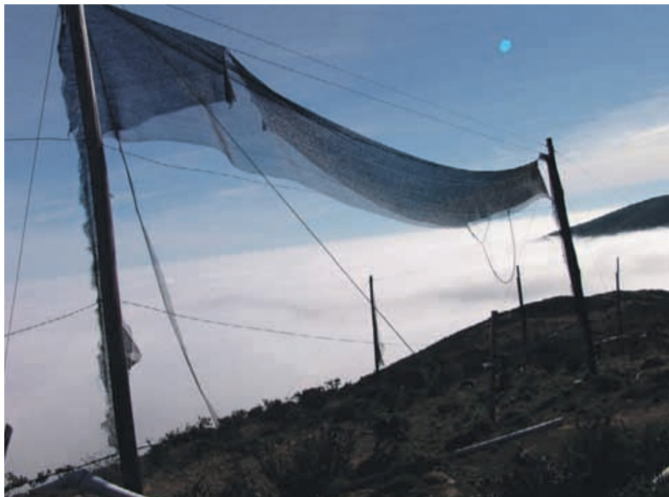
La experiencia que se desarrolló en Chungungo en 1992 finalmente no prosperó y la infraestructura con el tiempo se deterioró
