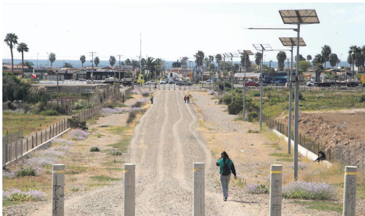
Se aprovechará la plataforma establecida como vía de evacuación para pavimentar la avenida Amanecer.
