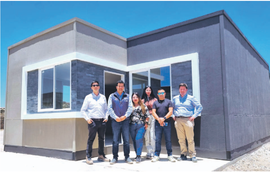
En Monte Patria se construirán las primeras 10 viviendas industrializadas de la región. CEDIDA
