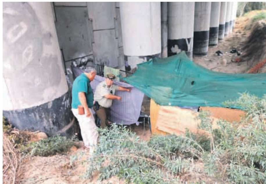
Bajo los pilares del puente Fiscal, también se emplazaba una pequeña toma que fue desalojada.
