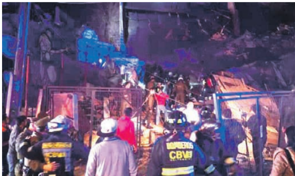
La estructura colapsó y varias personas resultaron lesionadas. Bomberos de equipo USAR lideraron labores de rescate.
