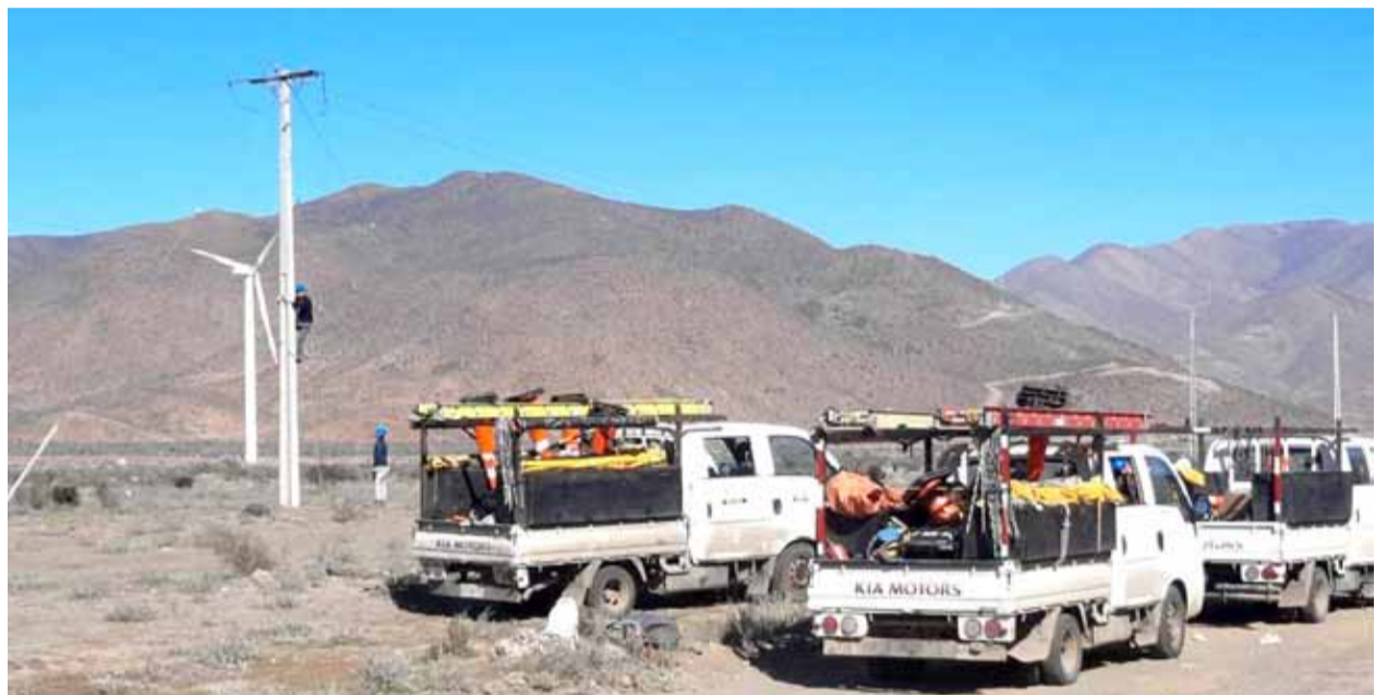
La sustracción de estas instalaciones afecta la calidad y continuidad del servicio para la población de extensas áreas del país.
