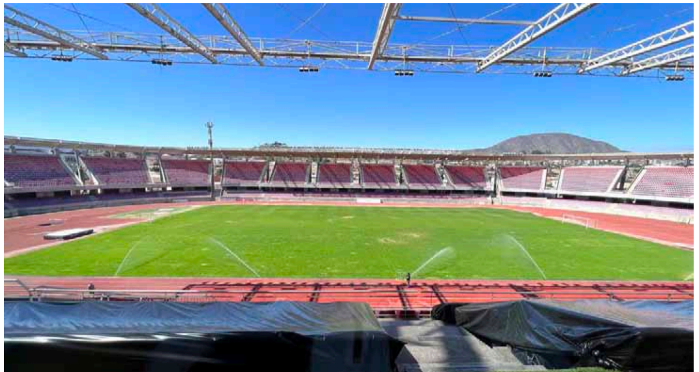
Así luce el Estadio La Portada a una semana del encuentro que, el 22 de abril, deben disputar ante Puerto Montt.
