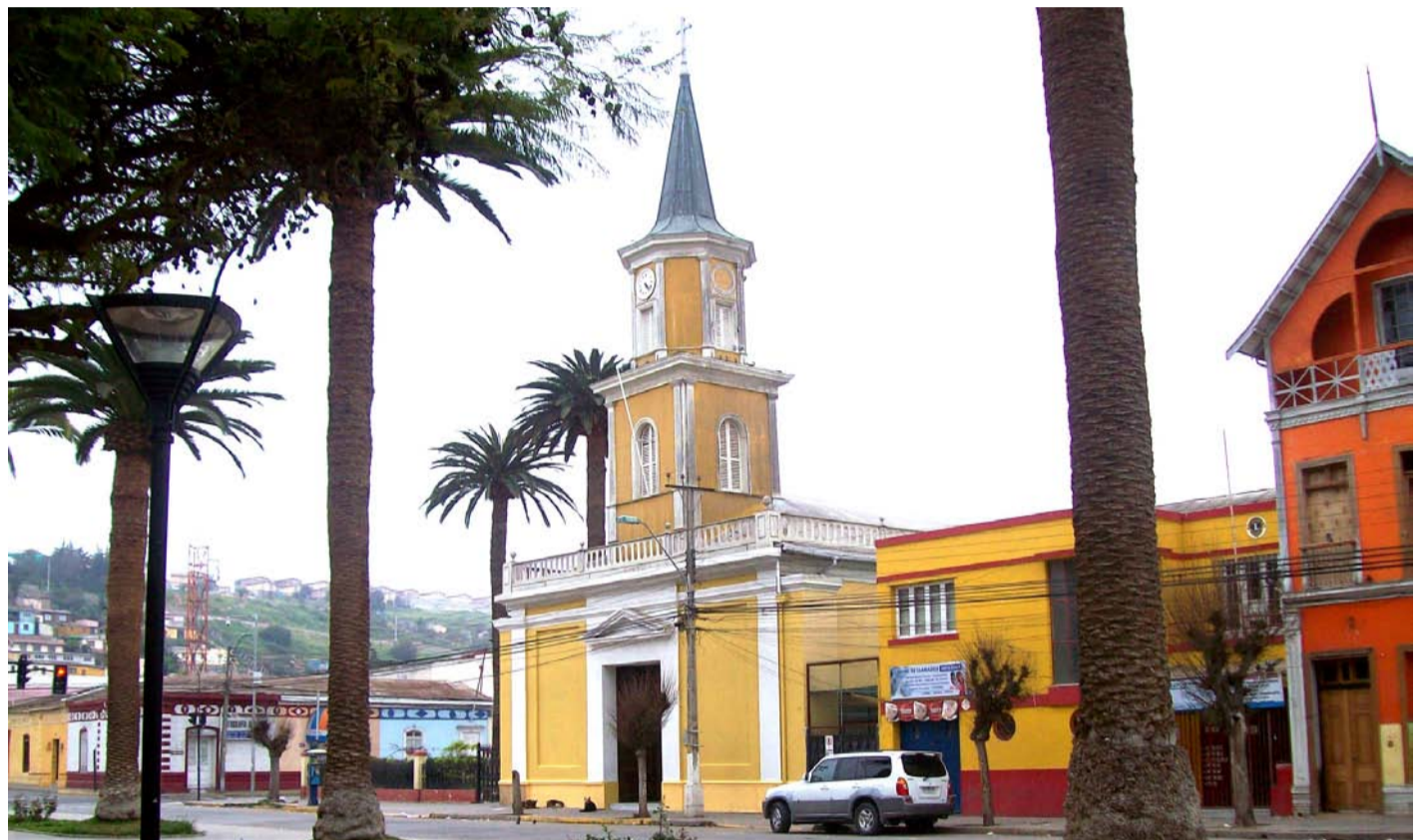
Pese al tiempo transcurrido, la iglesia San Vicente Ferrer aún sigue esperando por una pronta remodelación.
