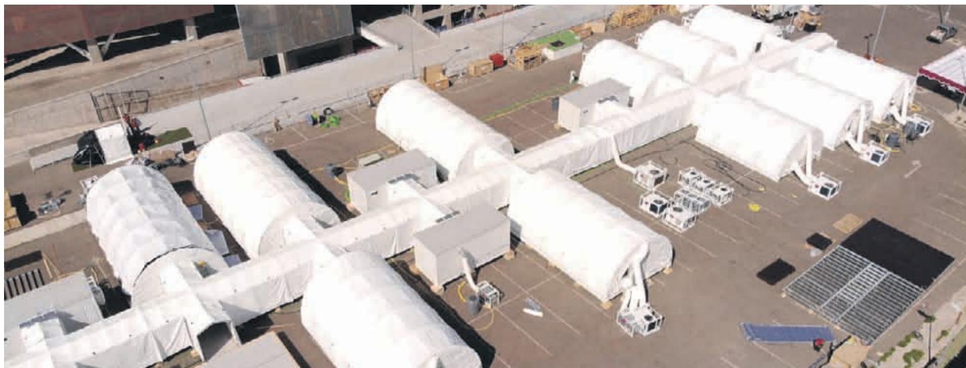
En total, son 35 los trabajadores que dan vida a esta construcción semi-permanente de rápido despliegue, 1.460 metros cuadrados y una inversión de 2.600 millones de pesos.
