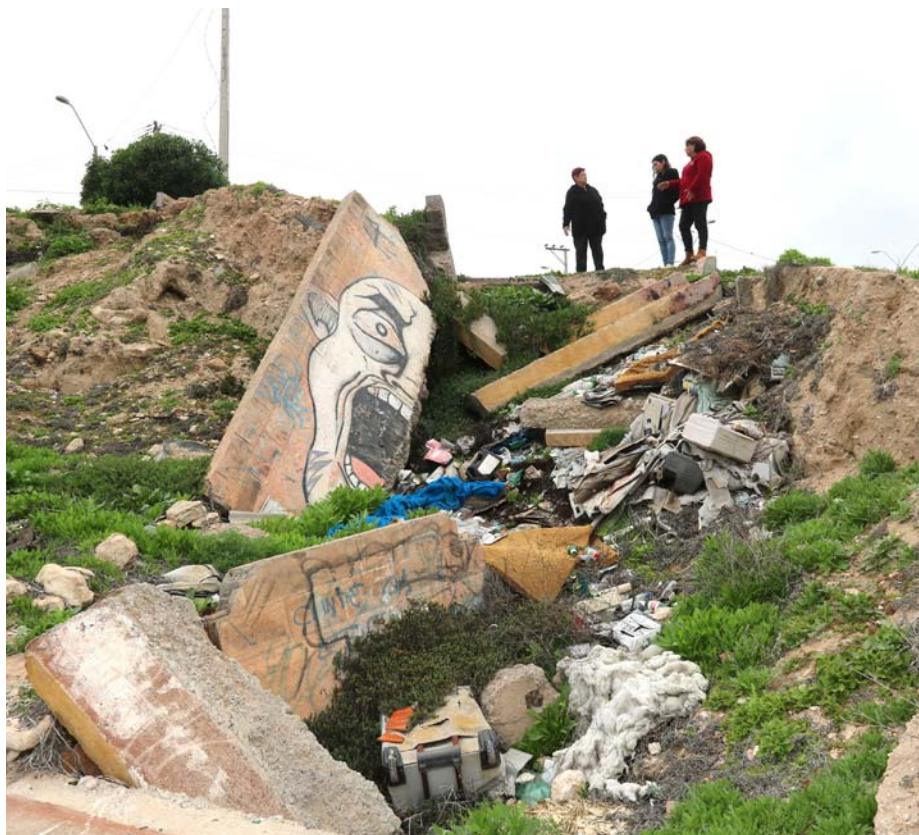
Cada lluvia genera alerta entre los vecinos de la calle Papa Telésforo, en la villa Talinay de Coquimbo, pues ya han visto desaparecer su plaza y ahora temen por sus viviendas.
