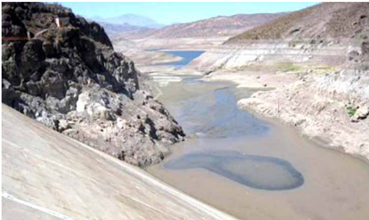
El embalse Cogotí se mantiene con niveles muy bajos de agua, lo que no alcanza a salir por las válvulas.
