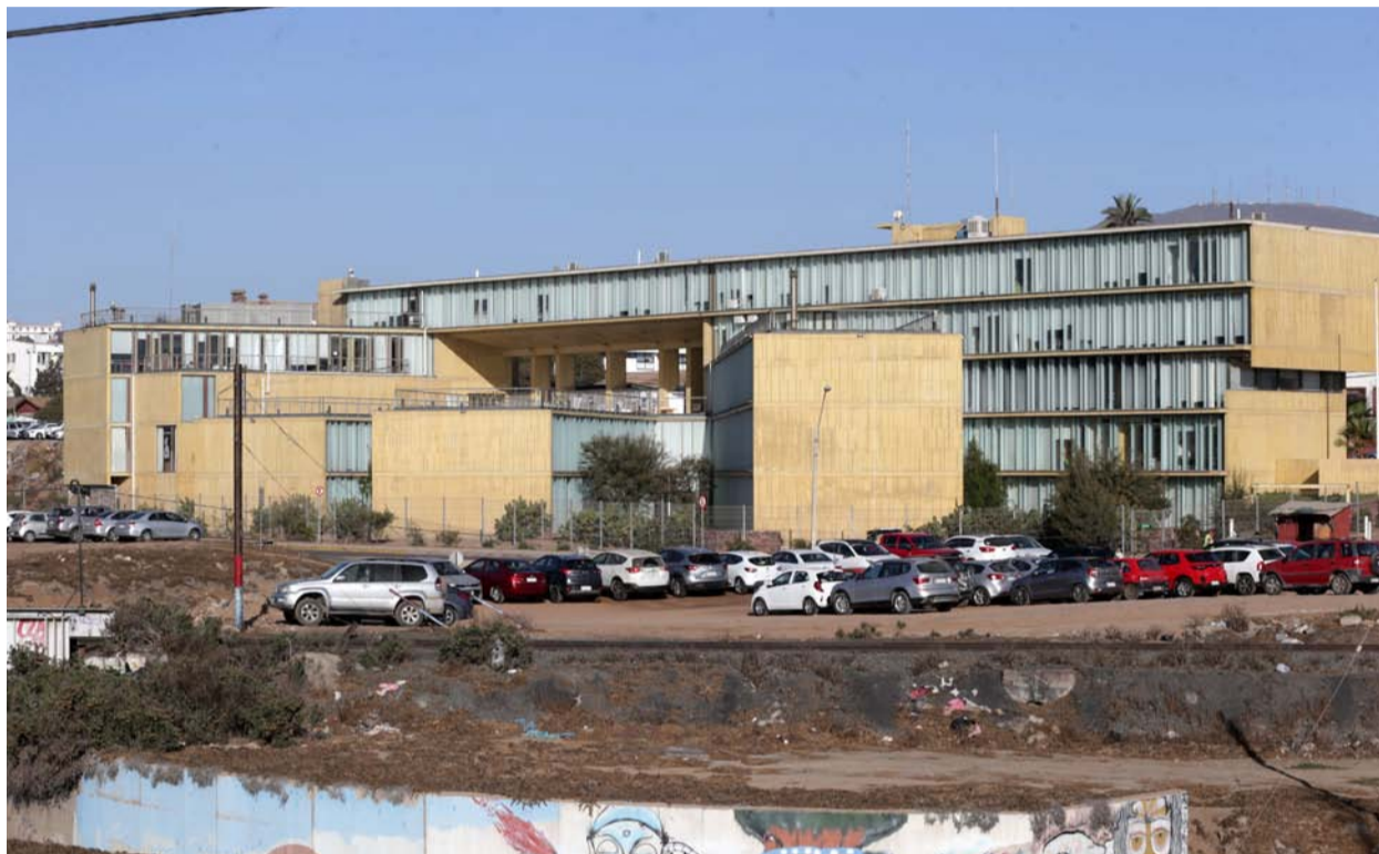
El Ministerio de Obras Públicas se encuentra desarrollando los estudios previos para la construcción de dos desaladoras multipropósito.
