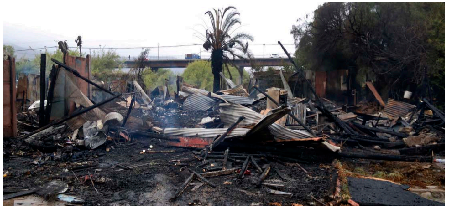
Dos viviendas totalmente destruidas dejó el incendio de ayer en la calle Almagro, en La Serena.
