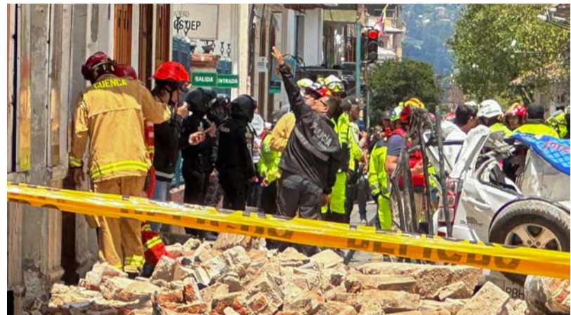
Personas observan los daños ocasionados por el sismo en Cuenca.
