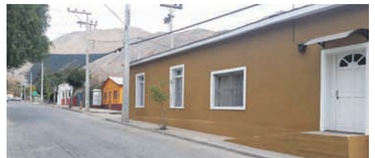
La reparación de las fachadas en la Avenida Principal del pueblo de Paihuano junto al proyecto de Barrio Elquino, buscan revitalizar esta vía de ingreso a la comuna.
