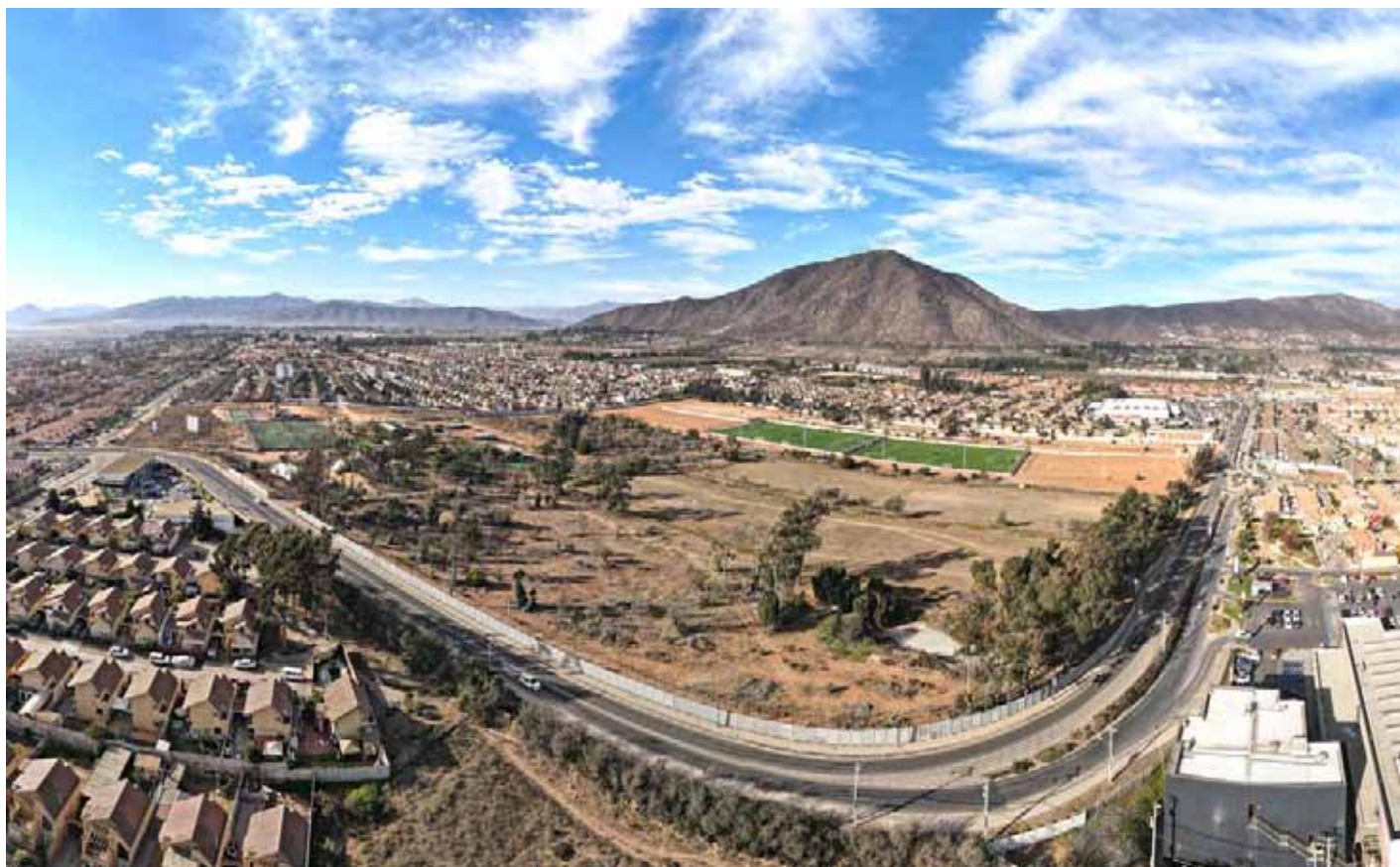
El futuro hospital se ubicará en los terrenos que antes pertenecían a la CORDEP.
