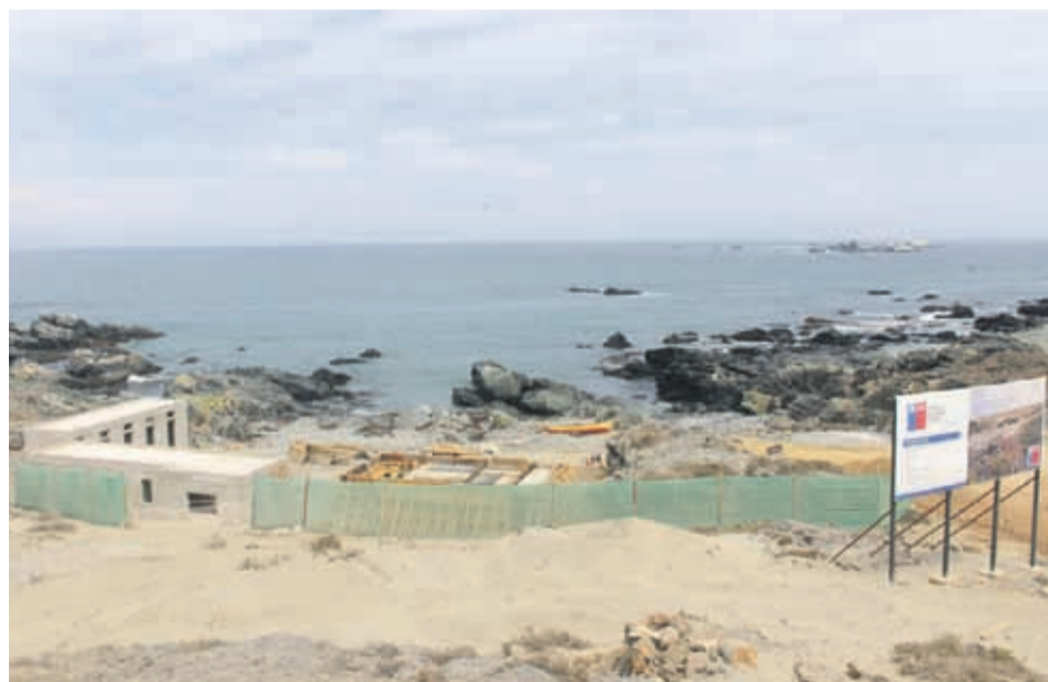
Un notorio avance presenta la construcción de las obras terrestres de la caleta El Apollado en la comuna de La Higuera. CEDIDA
