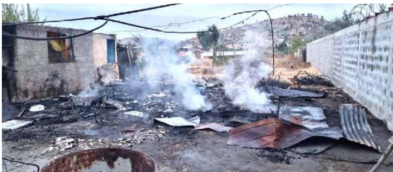
La vivienda incendiada en la comuna de Punitaqui quedó completamente destruida.
