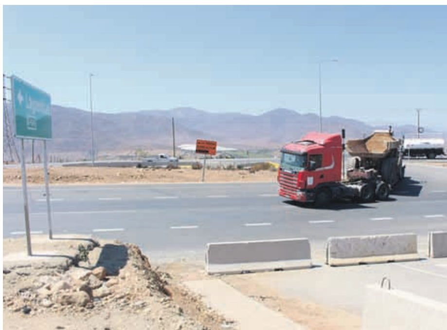
En el sector de Lagunillas existe un enlace que, según los conductores, es riesgoso. CEDIDA
