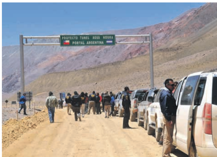
El Túnel de Agua Negra es considerada la obra más importante de la última década en América Latina.
