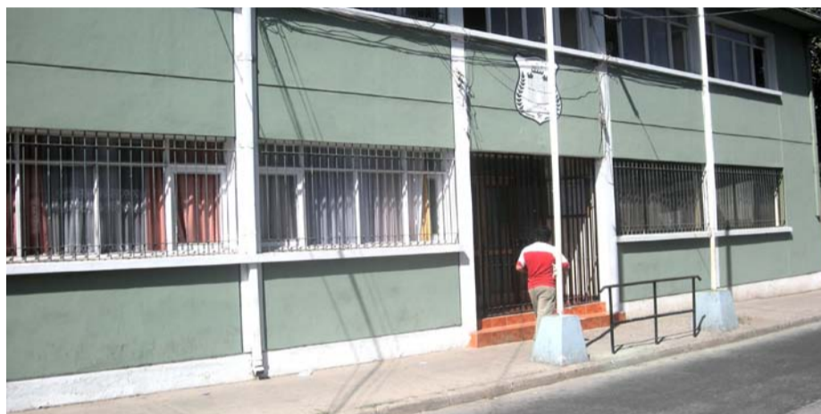
La cárcel de Illapel se encuentra a pocas cuadras de la Plaza de Armas y del municipio, en medio de viviendas y locales comerciales.
