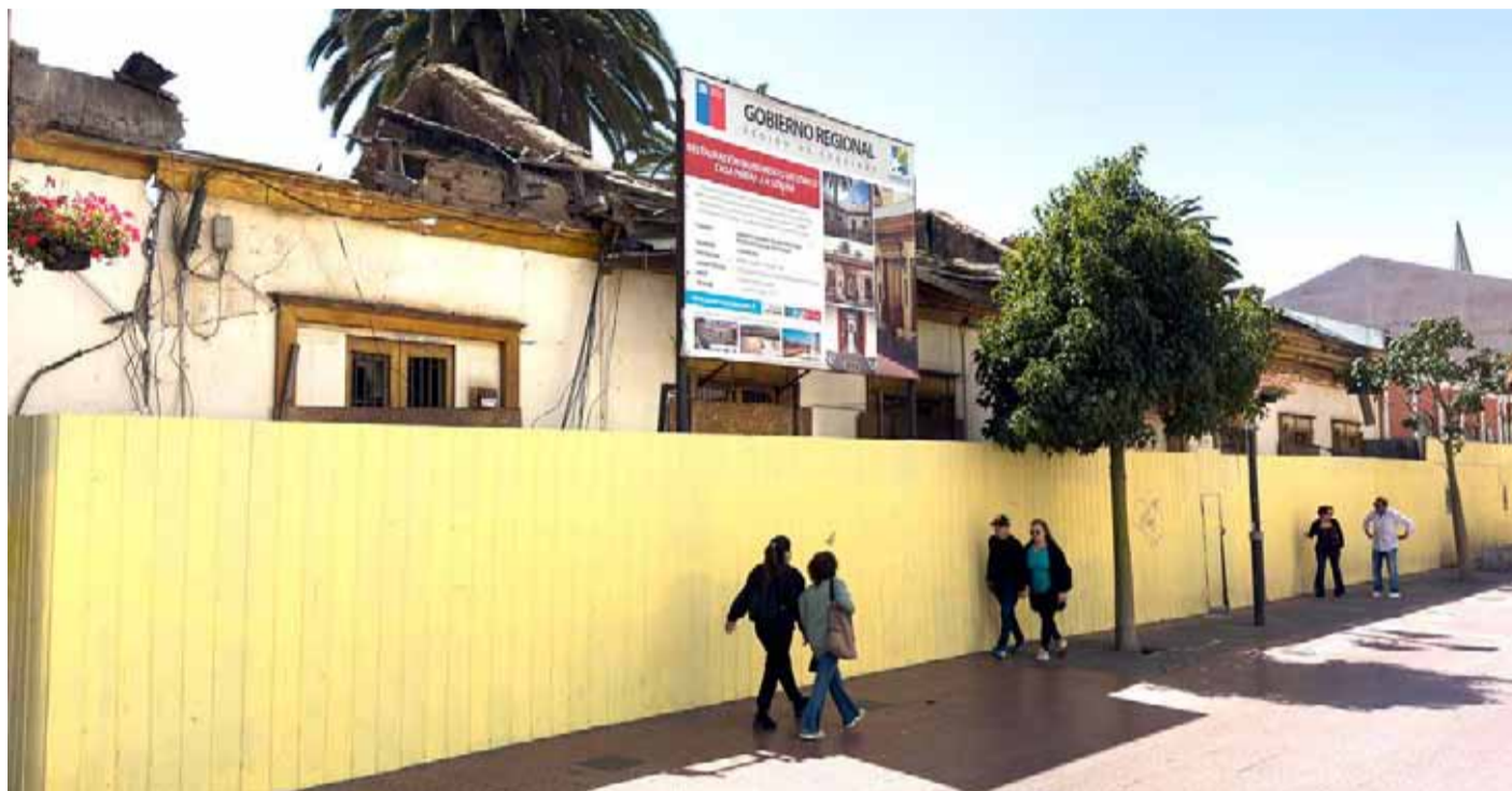
La Casa Piñera figura dentro de las estructuras que necesitan una urgente reparación en el centro histórico de La Serena.
