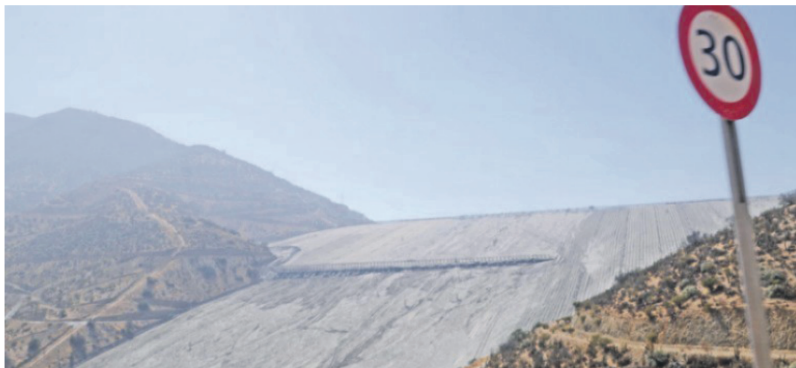
El tranque El Mauro, de Minera de Los Pelambres, ha sido el primero en instalar esta tecnología en un plan piloto.
