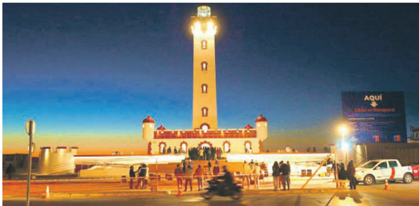
El Faro Monumental muestra una nueva cara tras la finalización de la segunda etapa del proyecto de restauración.
