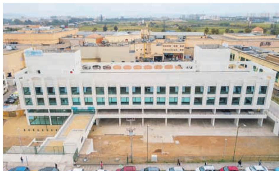
Desde hace algunas semanas, ya es posible observar avances concretos en la ampliación de la Clínica Red Salud Elqui, en La Serena.
