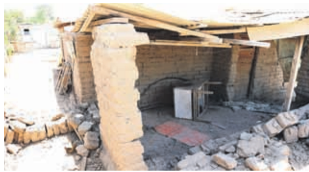
En Nueva Talcuna , comuna de Vicuña, también hubo casas que quedaron en el suelo.
