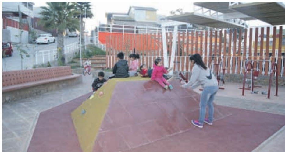
El Jardín Infantil y Sala Cuna "Los Changuitos" se encuentra abandonado hace varios años luego que la empresa a cargo de su construcción abandonara las obras.
