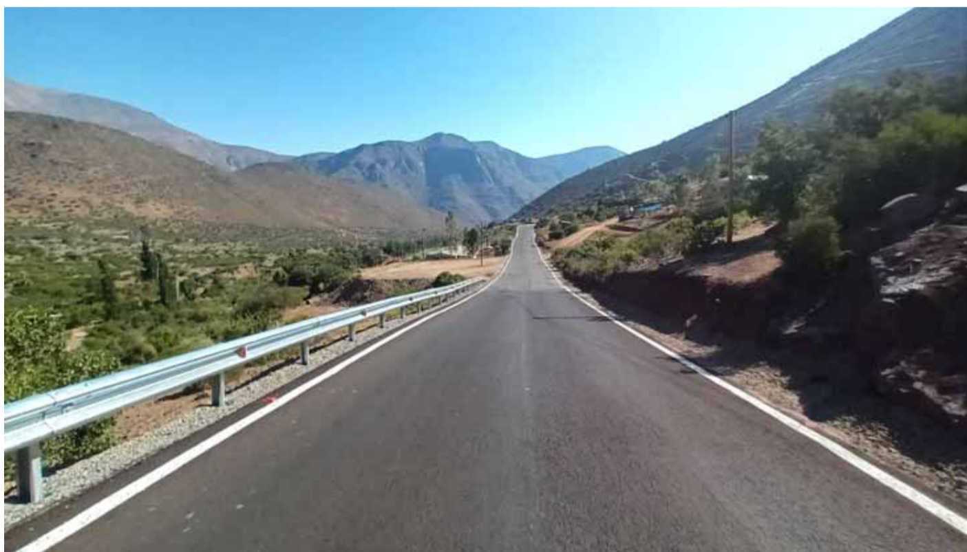
Mejoramiento del camino de la Ruta D-827, sector El Boldo, provincia del Choapa. CEDIDA
