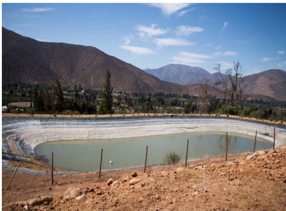
El proyecto consiste en la construcción de embalse de regulación corta con capacidad de 7.549 m 3 y revestimiento con geomembrana de 1 de mm.
