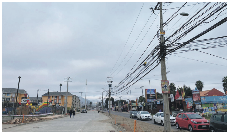
Los trabajos de mejoramiento del tramo de Cuatro Esquinas, entre la ruta 5 y la Avenida del Mar, fueron entregados durante el año pasado.
