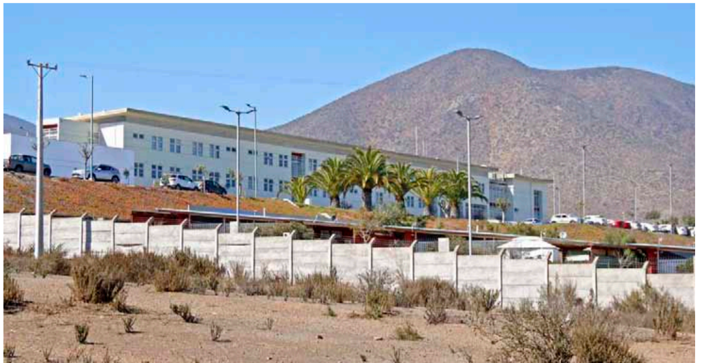
La actual capacidad del complejo penitenciario de Huachalalume llega a los 2.248 internos.
