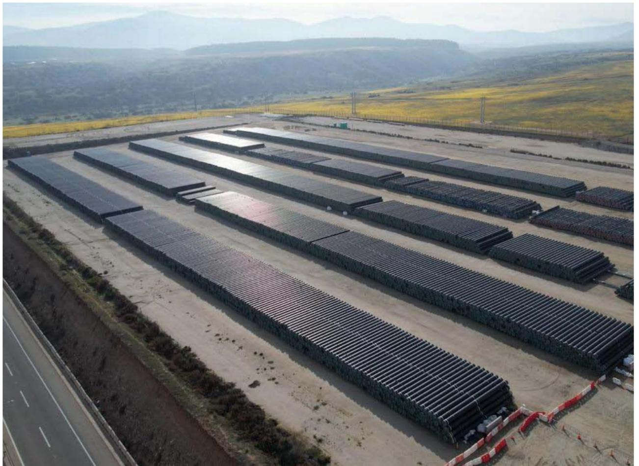
En total, el traslado consideró 17.131 tuberías, las que equivalen a más de 17 mil toneladas de acero, requirió de 1.472 viajes para su movimiento y un total de 59.149 horas hombre sólo para la descarga.
