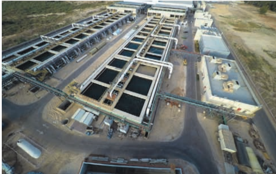
La planta de Sorek en Israel produce 624.000 m 3 al día de agua potable.
