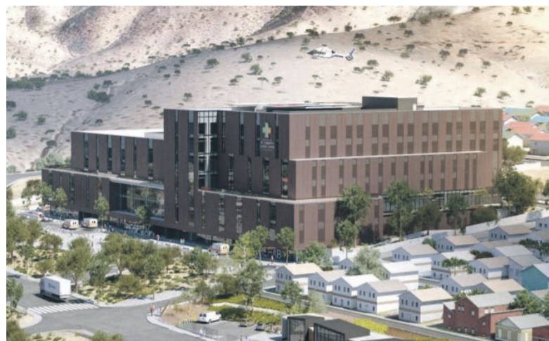
El futuro hospital de Illapel tendrá un total de 135 camas de hospitalización y 6 pabellones de cirugía mayor.
