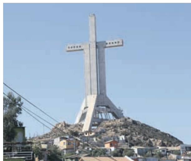
La obra está inconclusa ya que falta el recubrimiento y el Presidente Sebastián Piñera se habría comprometido con el fallecido edil Óscar Pereira.
